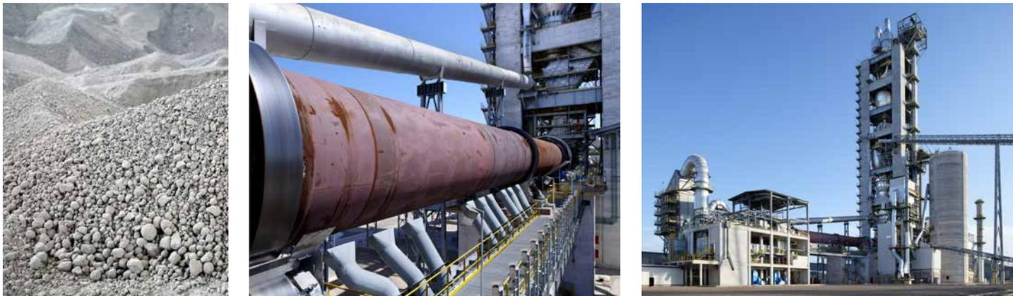
Planta de cemento con función de co-procesamiento (derecha), horno de cemento rotatorio (centro) y clínker de salida (izquierda).
